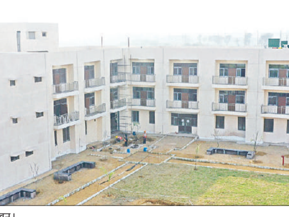
रेवाड़ी। माजरा में निर्माणाधीन एम्स का भवन।
